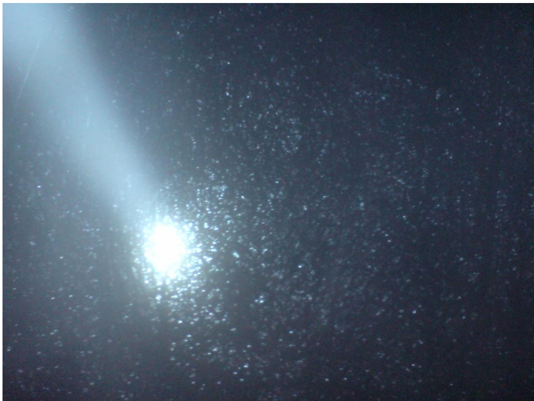
Рисунок 3.4 — Конденсация влаги в стволе ВС–7 в виде тумана на отметке – 600 м
