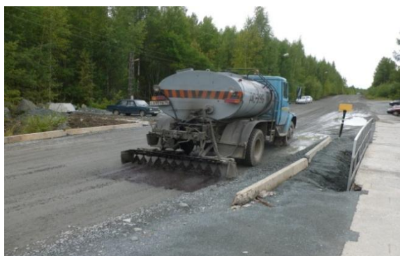
Рисунок 7 – Нанесение профилактической эмульсии на поверхность грунтовой дороги в ОАО «Святогор» при обеспыливании покрытия (слева), качество обработки с расходом 0,5 и 1 л/м 2 (справа)
