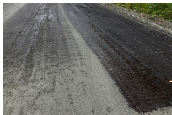
Рисунок 7 – Нанесение профилактической эмульсии на поверхность грунтовой дороги в ОАО «Святогор» при обеспыливании покрытия (слева), качество обработки с расходом 0,5 и 1 л/м 2 (справа)
