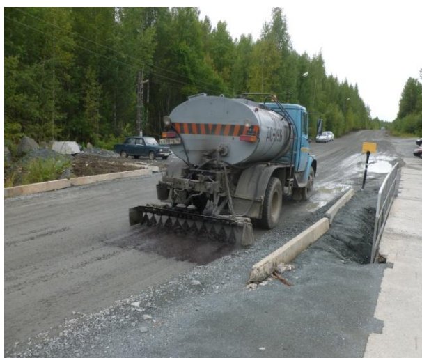
Рисунок 4.7 – Нанесение профилактической эмульсии автогудронатором ДС-39Б
