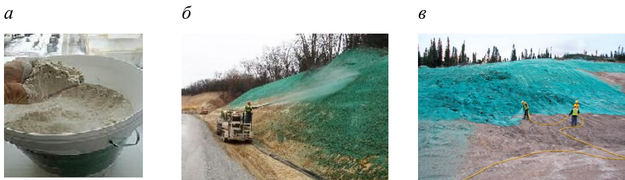
Рисунок 1.5 – Технология гидромульчирования перед рекультивацией: а – мульча на основе целлюлозы; б – гидромульчирование откосов автодорог; в – создание растительного слоя на поверхности породного отвала
