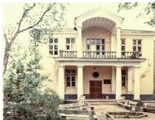
Рис.8. Здание горного института УрО РАН, 1988 г.
