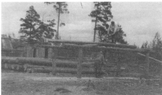
Д. В.-Лупья. Пилят плахи домной пилой. 1948 г.
